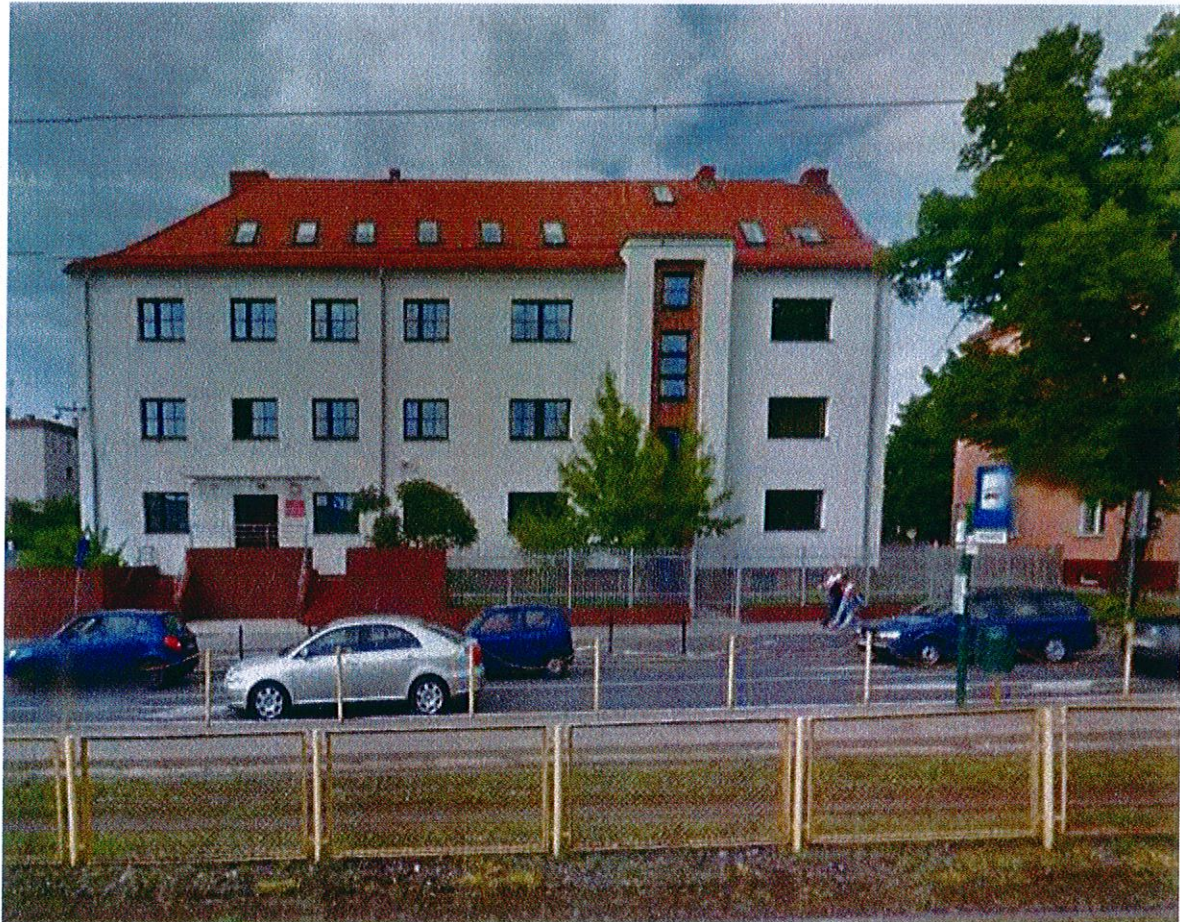
Rysunek 2 – Widok połaci dachowej, na której projektuje się system ogniw PV
